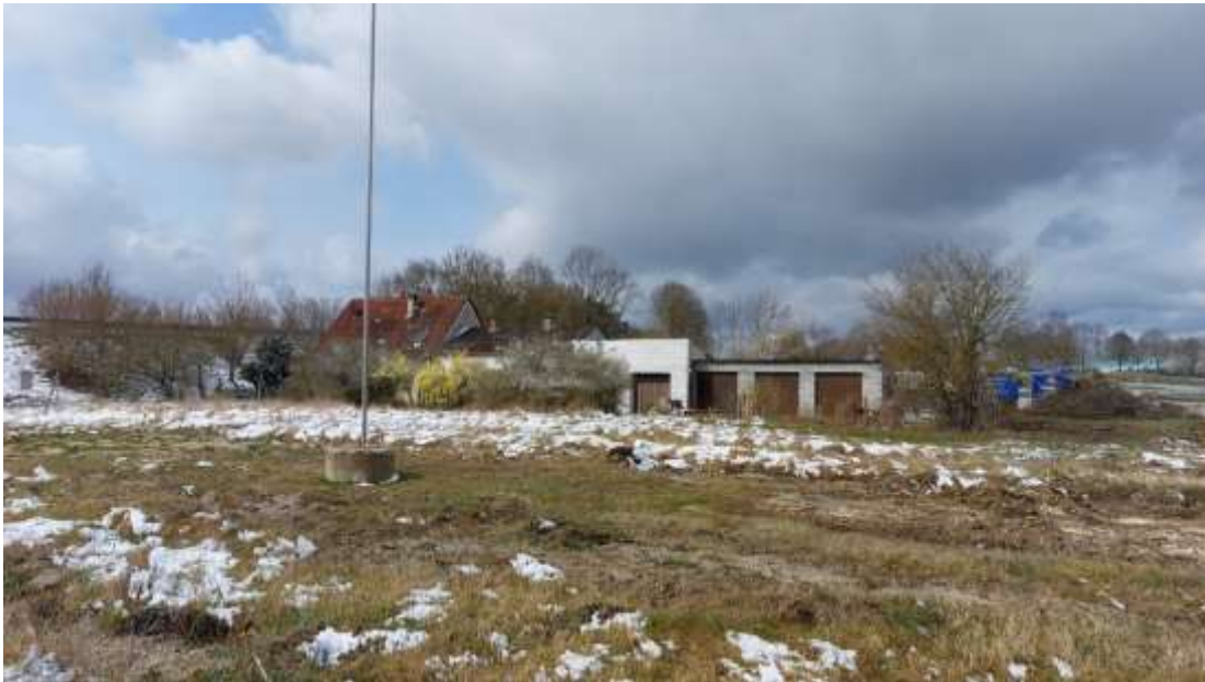
Fl. Nr. 2837/ 19 älteres Wohnhaus – Blick von Osten nach Westen
