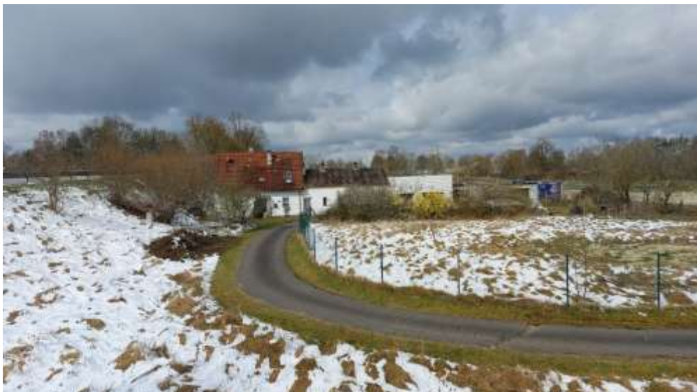
Blick von Osten nach Westen Fl. Nr. 2837/19 - Wohnhaus
