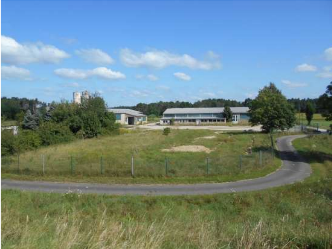
Fl. Nr. 2837 derzeitiger Zustand des Gebiets (Ausschnitt) – Blick von Süden nach Norden
