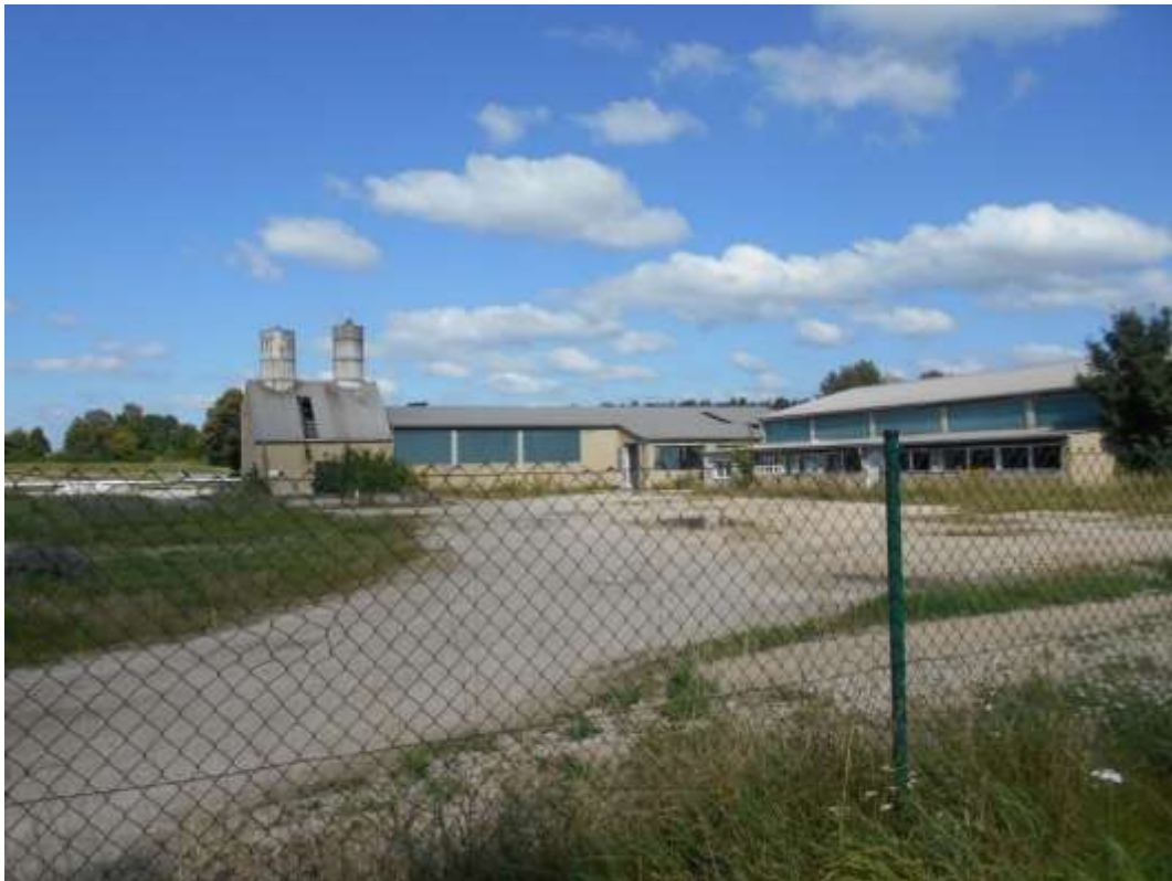
Fl. Nr. 2837 derzeitiger Zustand des Gebiets (Ausschnitt) – Blick von Südost nach Nordwest
