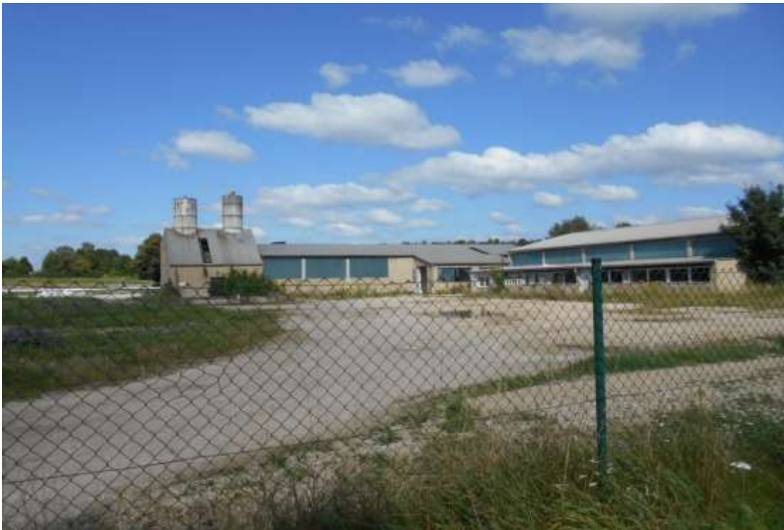
Fl. Nr. 2837 derzeitiger Zustand des Gebiets (Ausschnitt) – Blick von Südost nach Nordwest
